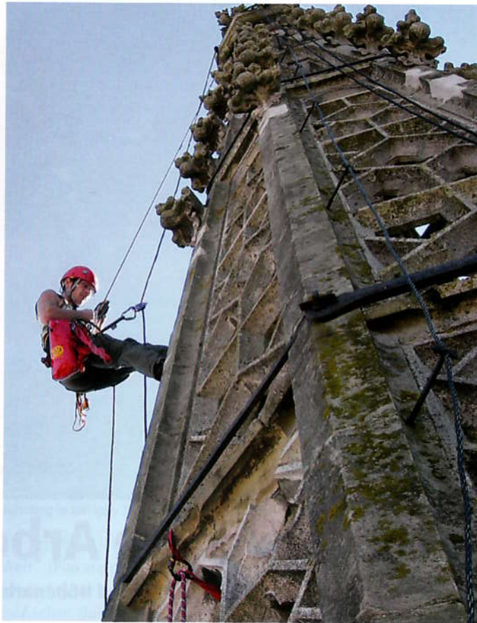
Bei den Renovierungsarbeiten an St. Jakob stieg Armin Ilgenfritz in luftige Höhen.
