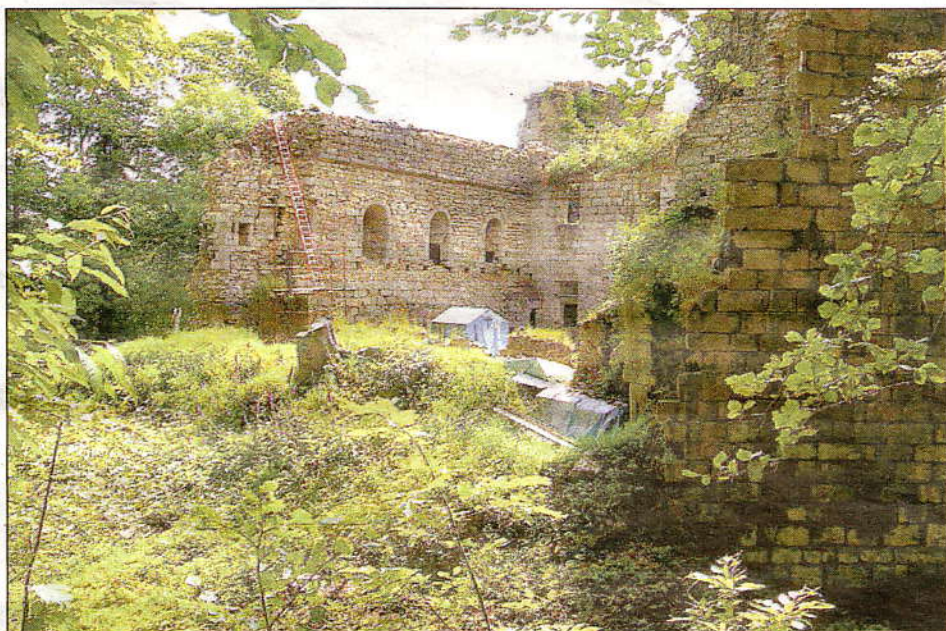
● Depuis 2001, le maire réclame au propriétaire de Coat Frec une demande de permis de construire. En 2005, il a pris un arrêté interdisant les travaux. Aujourd'hui, le tribunal interdit les caravanes et les cabanes de chantier (photo d'archives).
