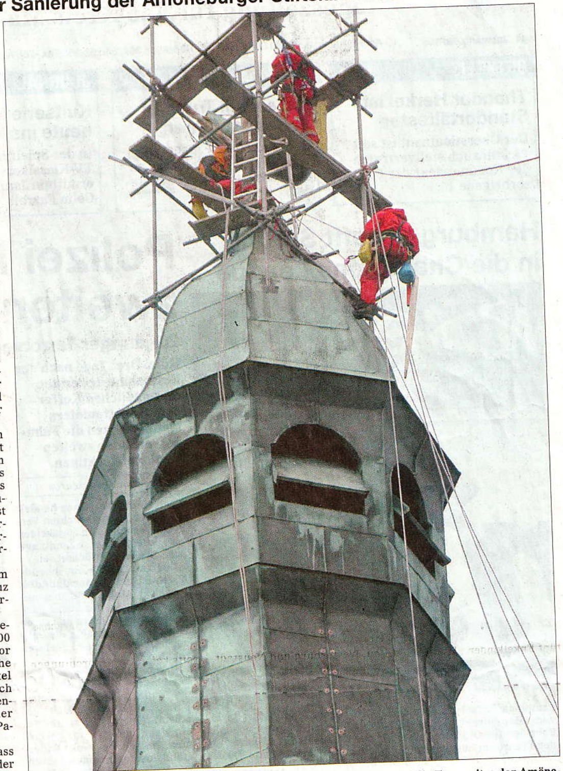
In luftiger Höhe montierten die Experten das Kreuz und den Gockel auf die Turmspitze der Amöneburger Stiftskirche. Fotos: Bodo Ganswindt
